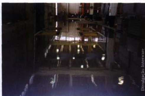
Foto 1: Piso com adequação para tráfego de veículos automáticos
